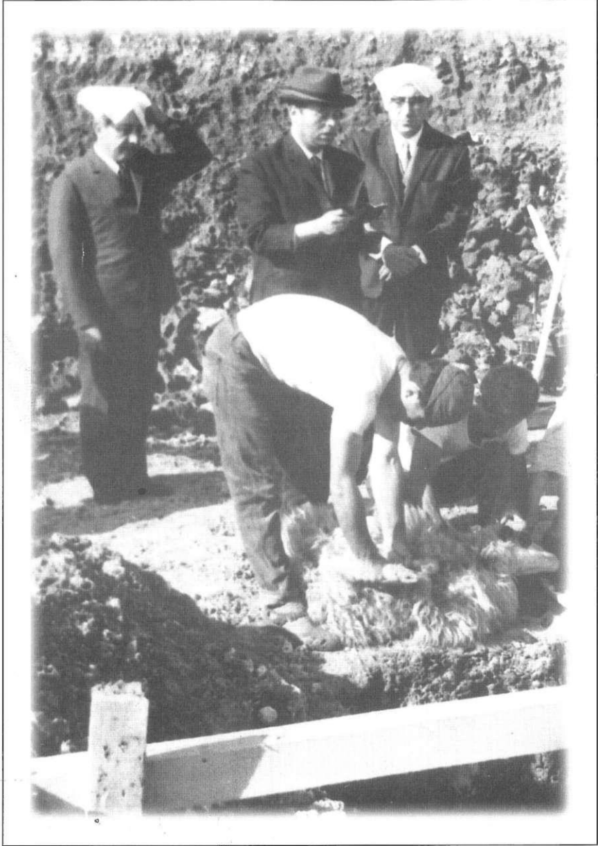
1 Ekim 1967. Albert, Fabrikanın temel atımı sırasında.
